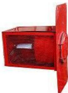
Генератор пены ГПСС 2000, 600 применяется в стационарных установках пожаротушения стальных вертикальных нефтяных резервуаров объемом 5000 м<sup>3</sup> и выше. Пена вводится в резервуар через пенокамеры, которые монтируются в верхнем поясе резервуара. Пена разрывая мембрану из промасленного картона или листового свинца, поступает на поверхность нефтепродукта и прекращает горение.
