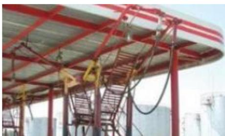
Стояк верхнего налива СНА 100 предназначен для налива темных нефтепродуктов и масел (с кинематической вязкостью 0,1 м/с) в автоцистерны, может использоваться в зонах с пожароопасностью класса П-1, П-2, П-3.
